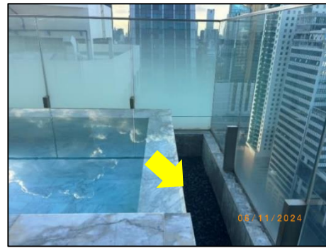
รูปที่ 2-81 รางระบายน้ำล้นสระว่ายน้ำ
