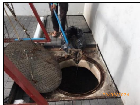
รูปที่ 2-31 การตัดไขมันในบ่อดักไขมัน
