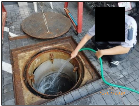
รูปที่ 2-33 การตรวจสอบและการทำความสะอาดบ่อพักน้ำ
