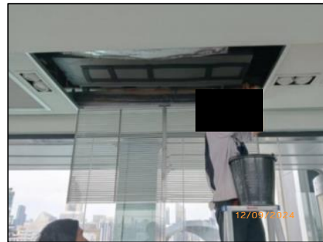
รูปที่ 2-20 การล้างเครื่องปรับอากาศ บริเวณพื้นที่ส่วนกลาง
