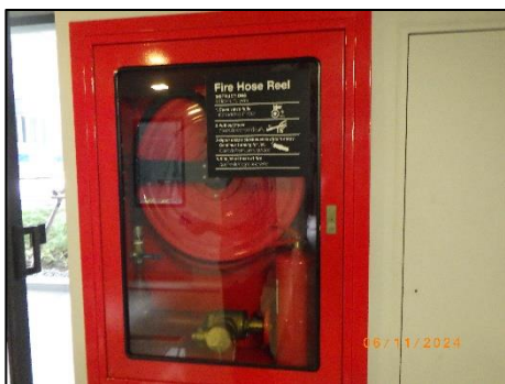
รูปที่ 2-47 ตู้เก็บสายฉีดน้ำดับเพลิง
