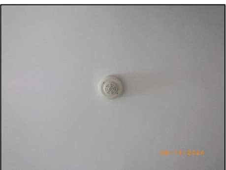
รูปที่ 2-43 เครื่องตรวจจับควัน
