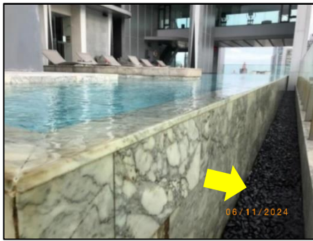
รูปที่ 2-81 รางระบายน้ำล้นสระว่ายน้ำ
