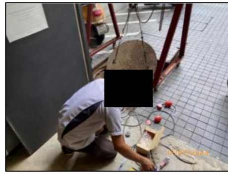
รูปที่ 2-33 การตรวจสอบและการทำความสะอาดบ่อพักน้ำ
