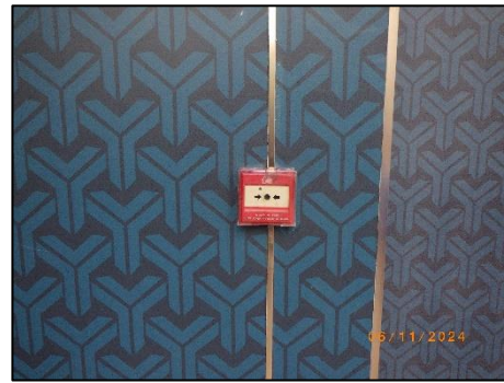
รูปที่ 2-45 อุปกรณ์ส่งสัญญาณแจ้งเหตุอัคคีภัย
