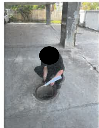
รูปที่ 2-7 แสดงเจ้าหน้าที่ดูแลระบบบำบัดน้ำเสียและตักตะกอนส่วนเกินออกจากระบบบำบัดน้ำเสีย
