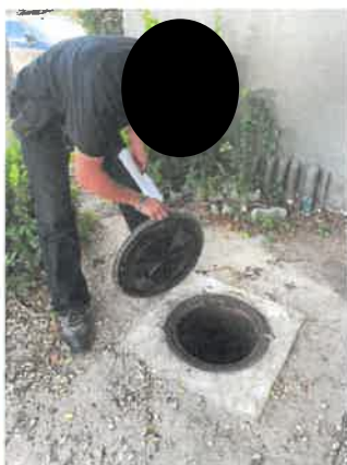
รูปที่ 2-7 แสดงเจ้าหน้าที่ดูแลระบบบำบัดน้ำเสียและตักตะกอนส่วนเกินออกจากระบบบำบัดน้ำเสีย
