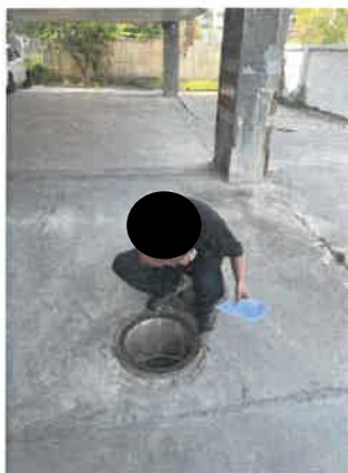
รูปที่ 2-7 แสดงเจ้าหน้าที่ดูแลระบบบำบัดน้ำเสียและตักตะกอนส่วนเกินออกจากระบบบำบัดน้ำเสีย
