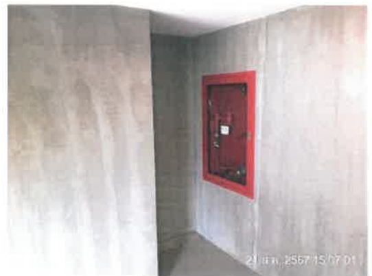
รูปที่ 2-32 แสดงตู้เก็บสายฉีดน้ำดับเพลิง (Fire Hose Cabinet) และถังดับเพลิงแบบมือถือ บริเวณข้างลิฟต์แต่ละชั้นของโครงการ
