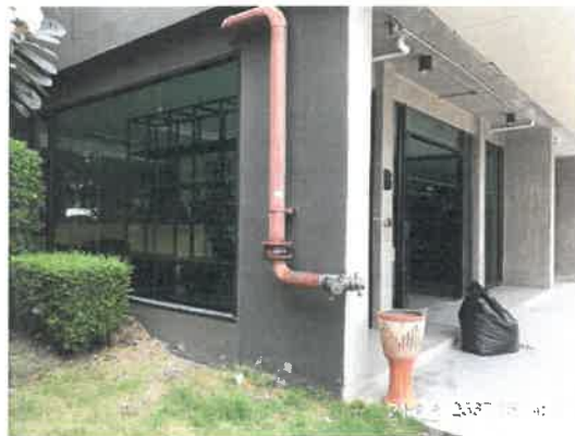
รูปที่ 2-36 แสดงติดตั้งหัวรับน้ำดับเพลิง FDC บริเวณด้านหน้าโครงการ
