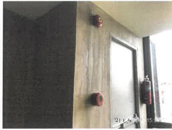
รูปที่ 2-35 แสดงกริ่งสัญญาณเตือนภัย และเครื่องแจ้งเหตุโดยใช้มือกด บริเวณภายในอาคาร
