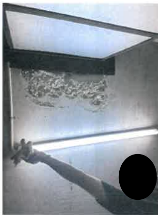
รูปที่ 2-24 แสดงเจ้าหน้าที่ทำความสะอาดหลอดไฟ และเปลี่ยนหลอดที่เสื่อมสภาพภายในโครงการ
