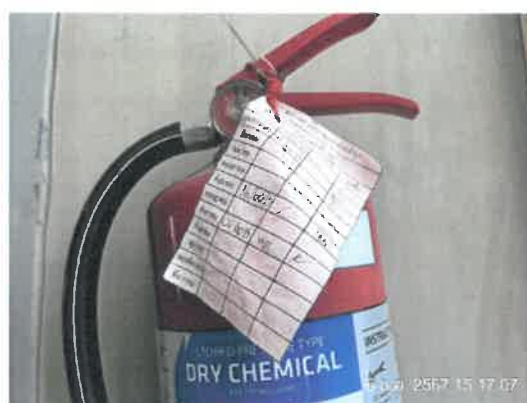
รูปที่ 2-39 แสดงการตรวจสอบอุปกรณ์ดับเพลิงภายในโครงการ
