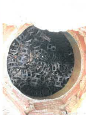
รูปที่ 2-5 แสดงระบบบำบัดน้ำเสียของโครงการ
