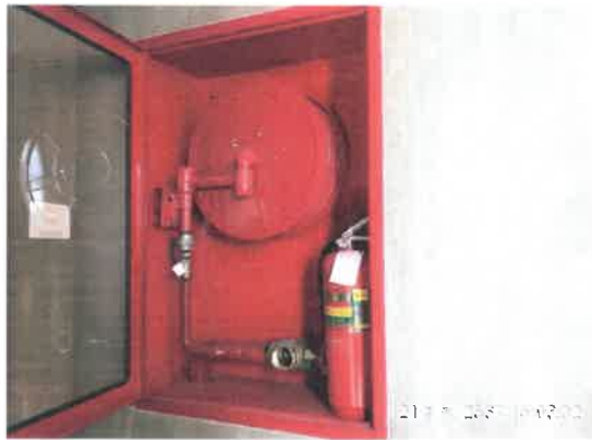
รูปที่ 2-32 แสดงตู้เก็บสายฉีดน้ำดับเพลิง (Fire Hose Cabinet) และถังดับเพลิงแบบมือถือ บริเวณข้างลิฟต์แต่ละชั้นของโครงการ
