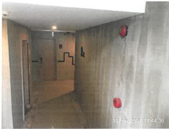
รูปที่ 2-35 แสดงกริ่งสัญญาณเตือนภัย และเครื่องแจ้งเหตุโดยใช้มือกด บริเวณภายในอาคาร
