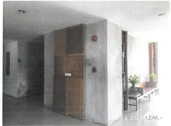
รูปที่ 2-35 แสดงกริ่งสัญญาณเตือนภัย (Alarm Bell) และเครื่องแจ้งเหตุโดยใช้มือกด (Fire Manual Station Unit)
