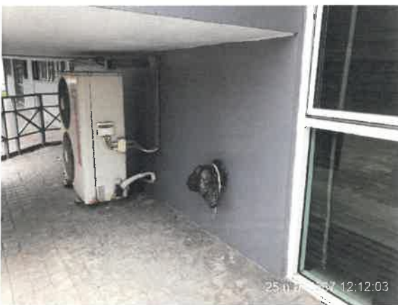
รูปที่ 2-36 แสดงติดตั้งหัวรับน้ำดับเพลิง FDC บริเวณที่จอดรถด้านข้างอาคารโครงการ
