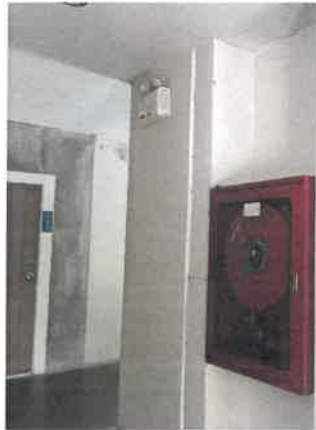
รูปที่ 2-35 แสดงกริ่งสัญญาณเตือนภัย (Alarm Bell) และเครื่องแจ้งเหตุโดยใช้มือกด (Fire Manual Station Unit)
