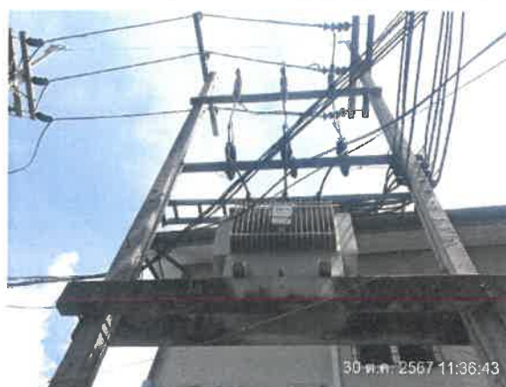
รูปที่ 2-26 แสดงหม้อแปลงไฟฟ้าของโครงการ
