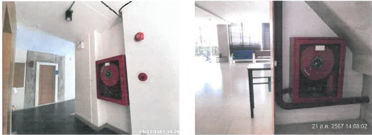
รูปที่ 2-32 แสดงตู้เก็บสายฉีดน้ำดับเพลิง (Fire Hose Cabinet) และถังดับเพลิงแบบมือถือ
