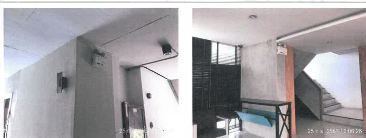
รูปที่ 2-34 แสดงระบบไฟส่องสว่างฉุกเฉิน (Emergency light)
