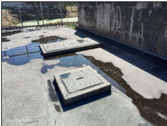
รูปที่ 23 ถังแยกน้ำ-น้ำมัน
