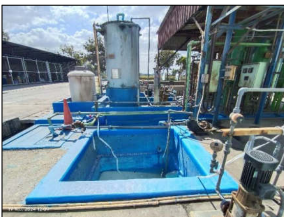
รูปที่ 31 บ่อรองรับน้ำทิ้งที่ผ่านการบำบัดแล้ว
