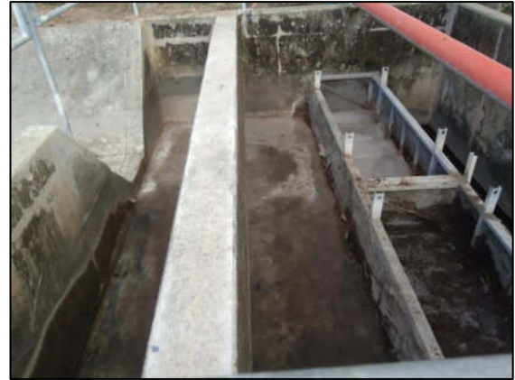
รูปที่ 28 การดักแกลบและขยะออกจากตะแกรง
