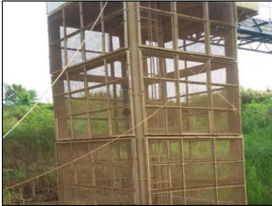
รูปที่ 33 การติดตั้งตะแกรงละเอียดบริเวณระบบสูบน้ำดิบ
