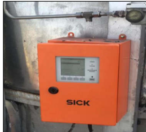
รูปที่ 47 อุปกรณ์ตรวจวัดฝุ่นละออง (Dust Detector)
