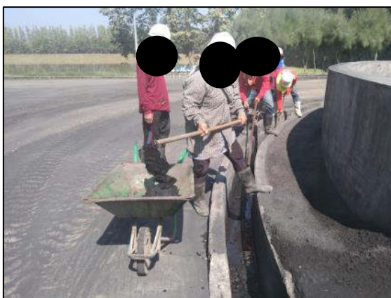
รูปที่ 21 การขุดลอกท่อระบายน้ำและลำรางสาธารณะ
