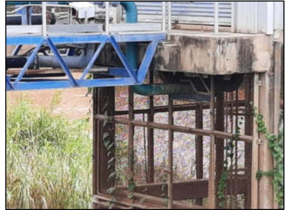
รูปที่ 33 การติดตั้งตะแกรงละเอียดบริเวณระบบสูบน้ำดิบ
