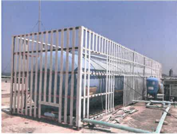
รูปที่ 2-10 แสดงถังเก็บน้ำสำรองชั้นตาดฟ้า
