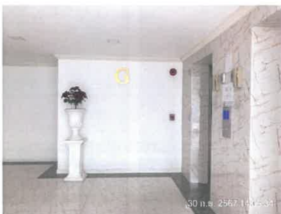
รูปที่ 2-45 แสดงกริ่งสัญญาณเตือนภัย (Alarm Bell) และเครื่องแจ้งเหตุโดยใช้มือกด (Fire Manual Station Unit)
