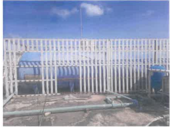
รูปที่ 2-10 แสดงถังเก็บน้ำสำรองชั้นตาดฟ้า
