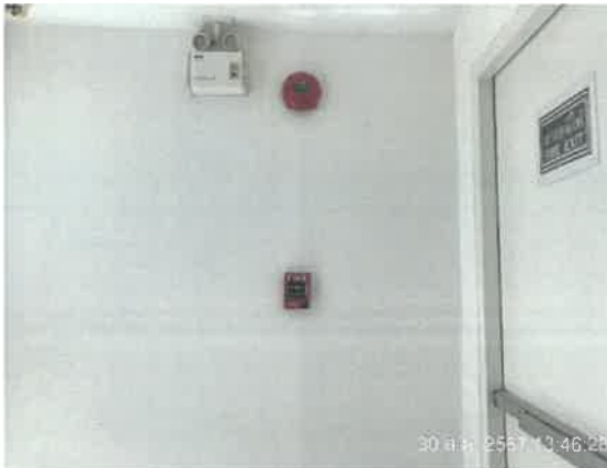
รูปที่ 2-45 แสดงกริ่งสัญญาณเตือนภัย (Alarm Bell) และเครื่องแจ้งเหตุโดยใช้มือกด (Fire Manual Station Unit)
