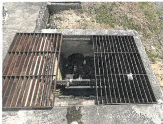
รูปที่ 2-18 แสดงบ่อพักน้ำ และตะแกรงดักมูลฝอย บริเวณจุดระบายน้ำออกจากท่อระบายน้ำของโครงการ
