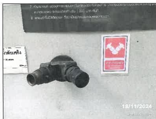
รูปที่ 36 ติดตั้งหัวรับน้ำดับเพลิงด้านหน้าโครงการ
