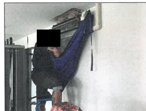
รูปที่ 38 ทำความสะอาดเครื่องปรับอากาศ
