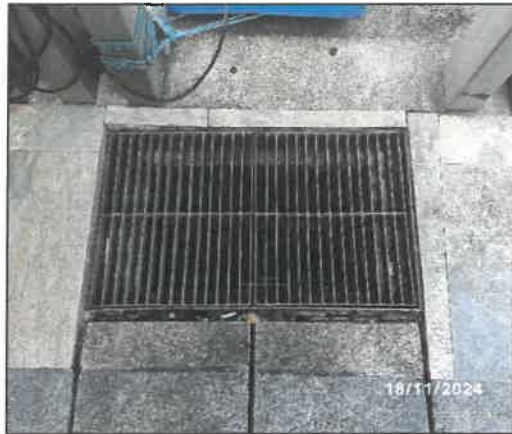
รูปที่ 6 ติดตั้งตะแกรงดักขยะมูลฝอยที่บ่อพักน้ำสุดท้ายของโครงการ
