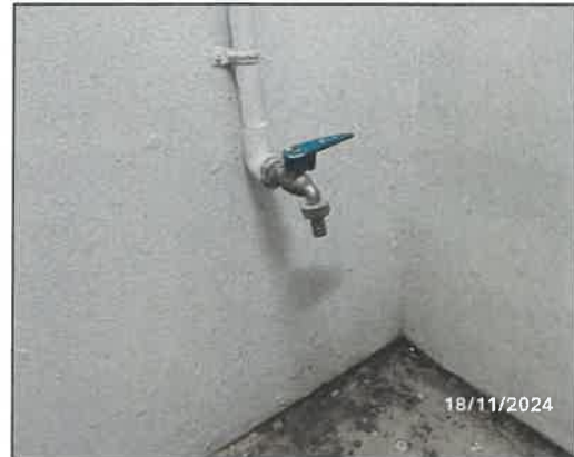
รูปที่ 19 ติดตั้งก๊อกน้ำและท่อระบายน้ำในห้องพักรถยนต์
