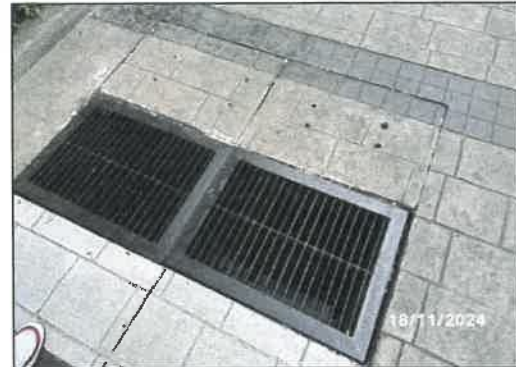
รูปที่ 28 ป่อทวงน้ำฝนบริเวณพื้นที่โครงการ
