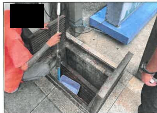
รูปที่ 29 ทำความสะอาดสิ่งอุดตันบริเวณป่อทวงน้ำและป่อพักน้ำ
