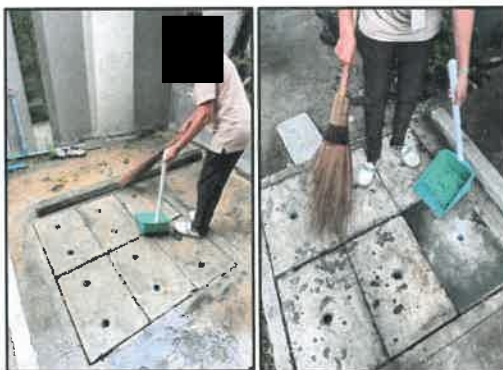
รูปที่ 29 ทำความสะอาดสิ่งอุดตันบริเวณป่อทวงน้ำและป่อพักน้ำ
