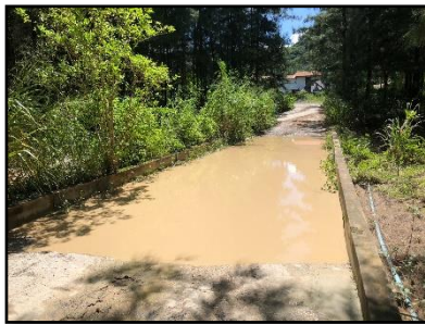
จัดสร้างลานล้างล้อ บริเวณทางเข้า-ออกพื้นที่โครงการ
