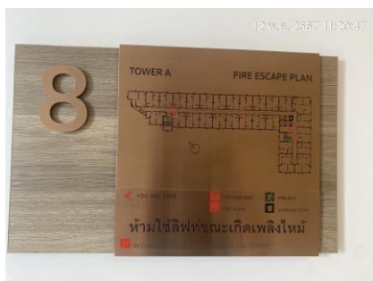
แผนผังแสดงเส้นทางหนีไฟและที่ตั้งอุปกรณ์ป้องกันอัคคีภัย รูปที่ 2.1-14 ระบบแจ้งเตือนและป้องกันอัคคีภัย (ต่อ)
