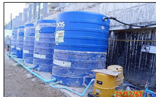
รูปที่ 2.2-4 ถังเก็บน้ำสำหรับอุปโภคของคนโครงการ
