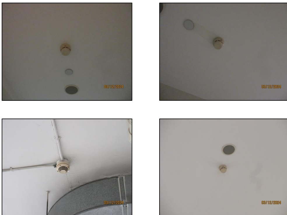
รูปที่ 35 Smoke Detector ภายในอาคารชุดคิวหลังสวน
