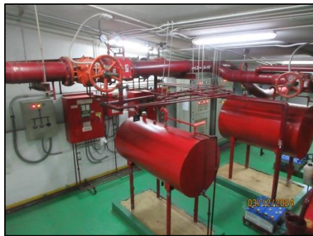
รูปที่ 26 เครื่องสูบน้ำดับเพลิง ชนิดเครื่องยนต์ดีเซล
