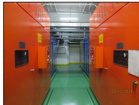
รูปที่ 22 ระบบไฟฟ้า Transformer ชนิด Dry Type Cast Resin ขนาด 2,000 KVA จำนวน 2 ชุด
