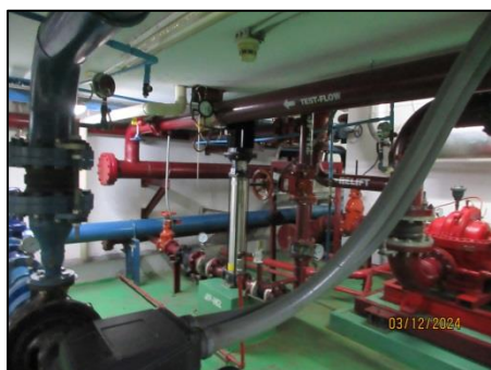
รูปที่ 27 ระบบท่ออื่น ใช้ท่ออื่นที่มีขนาดเส้นผ่านศูนย์กลาง 6 นิ้ว สำหรับพื้นที่ Low Zone และ High Zone
