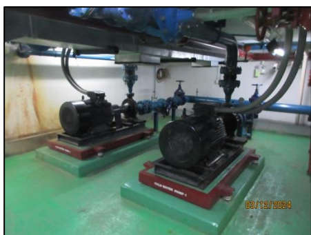
รูปที่ 14 เครื่องสูบน้ำของอาคารชุดคิวหลังสวน
