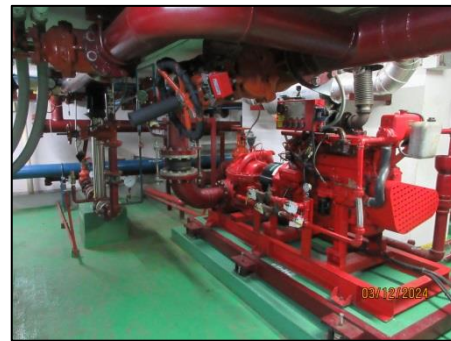
รูปที่ 26 เครื่องสูบน้ำดับเพลิง ชนิดเครื่องยนต์ดีเซล
