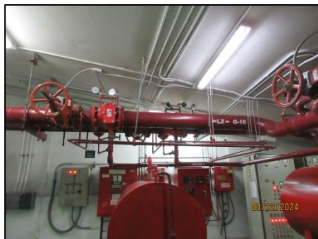
รูปที่ 26 เครื่องสูบน้ำดับเพลิง ชนิดเครื่องยนต์ดีเซล
