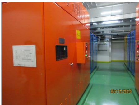
รูปที่ 22 ระบบไฟฟ้า Transformer ชนิด Dry Type Cast Resin ขนาด 2,000 KVA จำนวน 2 ชุด
