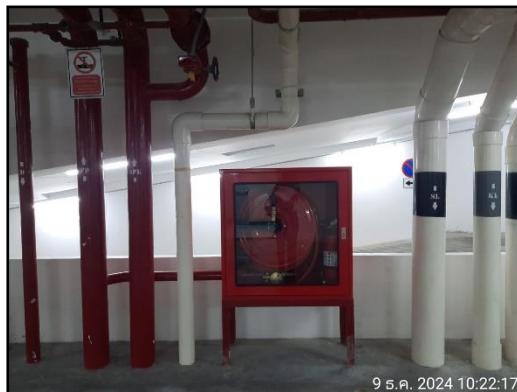
รูปที่ 52 (ต่อ) ระบบท่อเย็น หัวรับจ่ายน้ำดับเพลิง และตู้เก็บสายฉีดน้ำดับเพลิง
