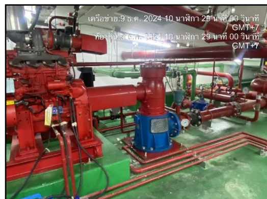
รูปที่ 54 ระบบน้ำสำรองเพื่อการดับเพลิง
