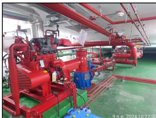
รูปที่ 54 ระบบน้ำสำรองเพื่อการดับเพลิง
