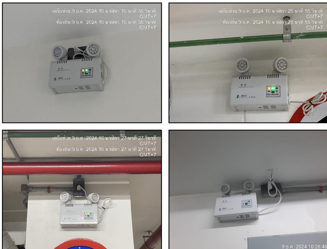
รูปที่ 48 ไฟฉุกเฉินอัตโนมัติ
