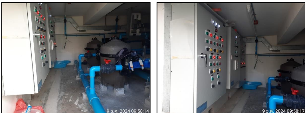
รูปที่ 33 ห้องเครื่องระบบสระว่ายน้ำ
