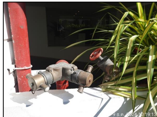
รูปที่ 52 (ต่อ) ระบบท่อเย็น หัวรับจ่ายน้ำดับเพลิง และตู้เก็บสายฉีดน้ำดับเพลิง
