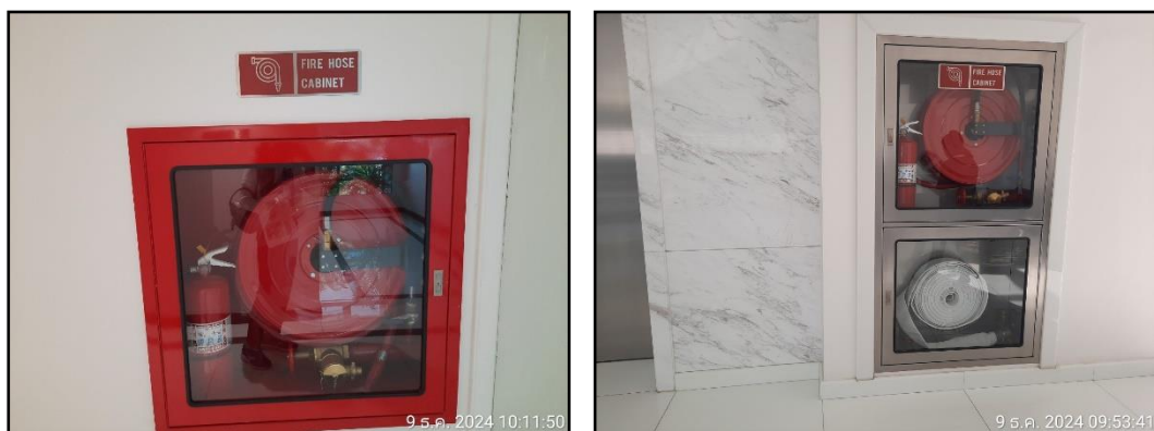
รูปที่ 52 ระบบท่อขึ้น หัวรับจ่ายน้ำดับเพลิง และตู้เก็บสายฉีดน้ำดับเพลิง
