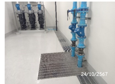
เครื่องสูบน้ำของระบบระบายน้ำ
