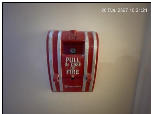
รูปที่ 52 อุปกรณ์เตือนภัยแบบใช้มือดึง
