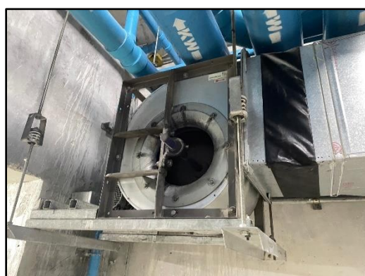
รูปที่ 14 พัดลมดูดอากาศและระบายอากาศ
