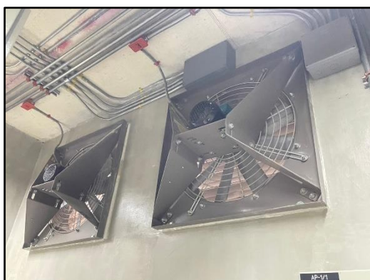
รูปที่ 14 พัดลมดูดอากาศและระบายอากาศ
