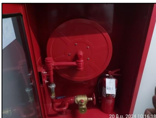
รูปที่ 50 ตู้เก็บสายฉีดดับเพลิง
