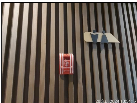
รูปที่ 52 อุปกรณ์เตือนภัยแบบใช้มือดึง
