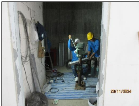
รูปที่ 11 การตัด หรือเจียร ทำในพื้นที่ผนังปิดด้านข้าง 3 ด้าน
