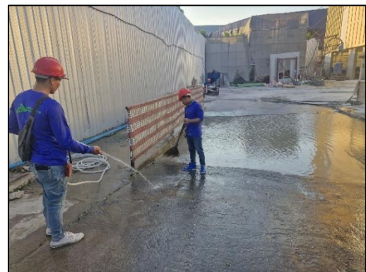
รูปที่ 88 การขุดลอกตะกอนที่สะสมในบ่อล้างล้อ
