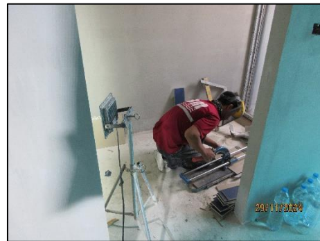
รูปที่ 11 การตัด หรือเจียร ทำในพื้นที่ผนังปิดด้านข้าง 3 ด้าน
