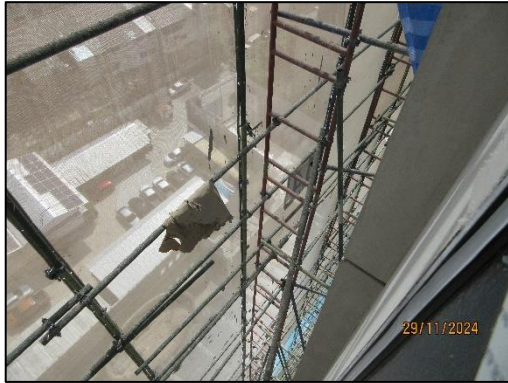
รูปที่ 93 โครงเหล็กโดยรอบตัวอาคาร และปิดชิงช่องว่างด้วยผ้าใบทึบ
