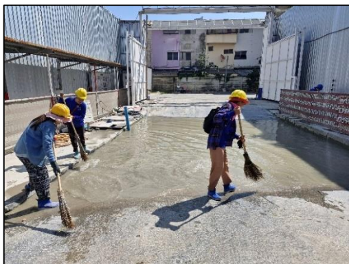
รูปที่ 88 การขุดลอกตะกอนที่สะสมในบ่อล้างล้อ
