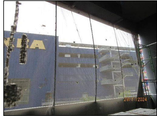
รูปที่ 93 โครงเหล็กโดยรอบตัวอาคาร และปิดชิงช่องว่างด้วยผ้าใบทึบ
