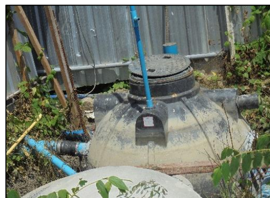
รูปที่ 1-6 ระบบบำบัดน้ำเสียสำเร็จรูปของโครงการ
