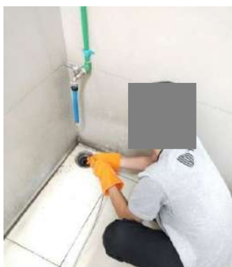
รูปที่ 2-56 ทำความสะอาดท่อน้ำทิ้งไม่ให้มีเศษอาหารคั่วหรืออุดตัน
