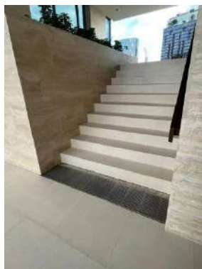
รูปที่ 2-50 ตะแกรงครอบตามรูปท่อระบายน้ำทั้งภายในและภายนอกอาคาร
