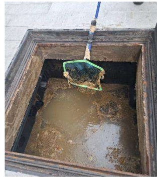
รูปที่ 2-53 ตักตะกอนส่วนเกินจากระบบบำบัด น้ำเสีย
