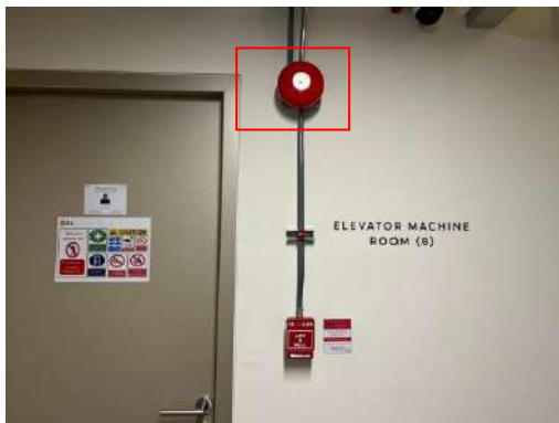
เครื่องแจ้งเหตุเพลิงไหม้ (Fire Alarm Speaker)
