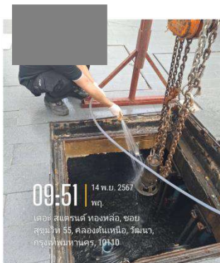
รูปที่ 2-51 ทำความสะอาดบ่อพักน้ำระบบบำบัดน้ำเสีย
