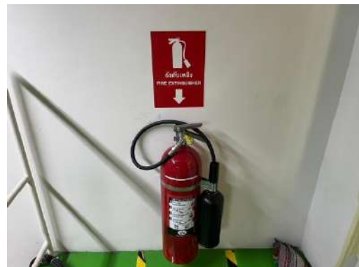
ถังดับเพลิงแบบมือถือ ขนาด 10 ปอนด์
