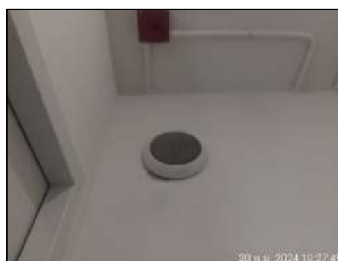
รูปที่ 27 ลำโพงแจ้งเตือนเพลิงไหม้
