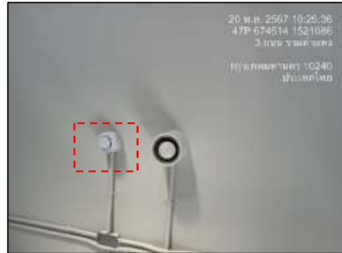
รูปที่ 29 เครื่องตรวจจับควันและความร้อน
