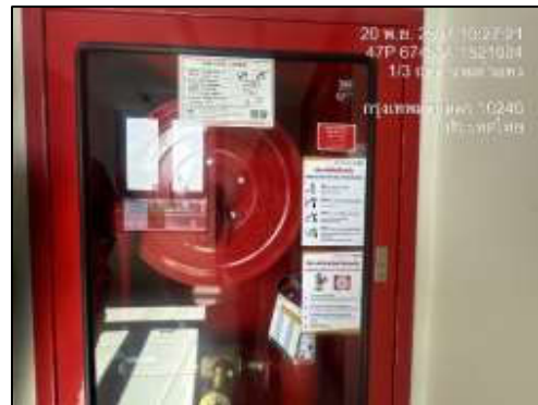
รูปที่ 31 ตู้เก็บสายน้ำดับเพลิง (FHC)
