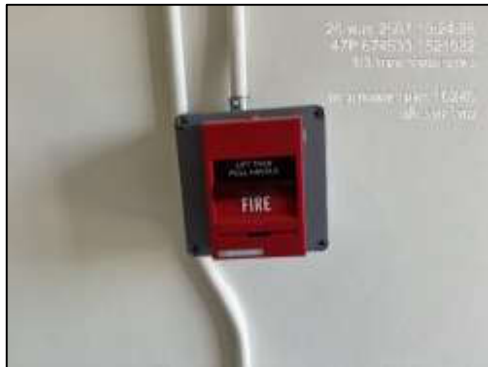
รูปที่ 28 ชุดกดแจ้งเหตุแบบใช้มือ
