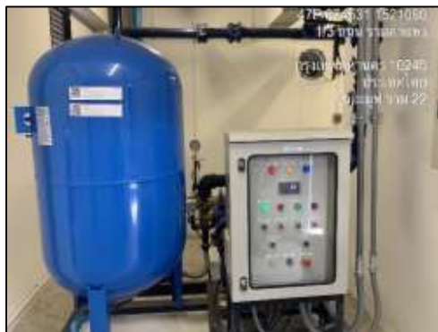
รูปที่ 20 เครื่องสูบน้ำ
