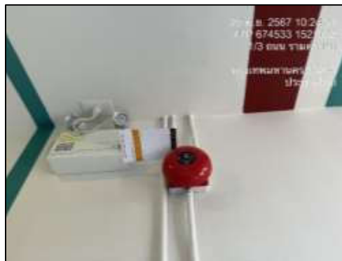
รูปที่ 30 จุดเต้ารับโทรศัพท์ในระบบแจ้งเหตุเพลิงไหม้
