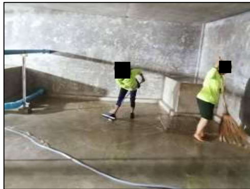
รูปที่ 12 เจ้าหน้าที่ล้างถังเก็บน้ำใต้ดิน
