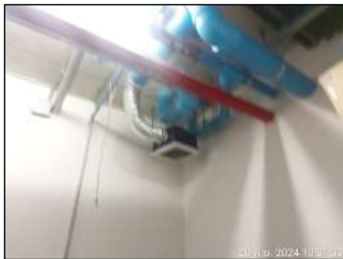
รูปที่ 18 ระบบระบายอากาศในห้องพักมูลฝอย
