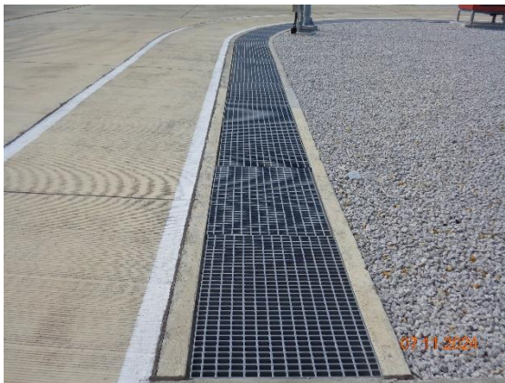
รูปที่ 2-18 ระบบระบายน้ำฝนในพื้นที่โครงการ
