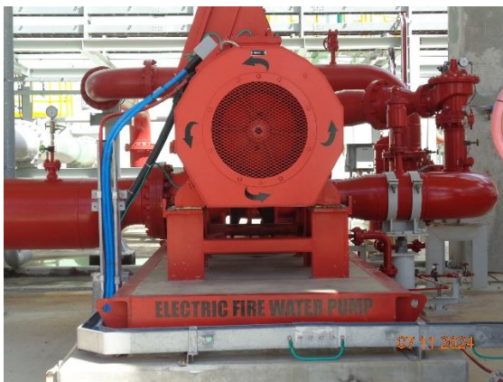
รูปที่ 2-52 เครื่องสูบน้ำใช้ไฟฟ้า (Electric Motor Firewater Pump)
