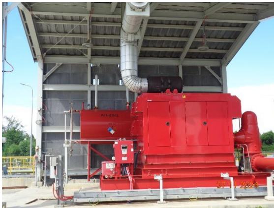
รูปที่ 2-54 เครื่องสูบน้ำทะเลสำรอง โดยใช้น้ำมันดีเซล (Diesel Driven Seawater Fire Pump)
