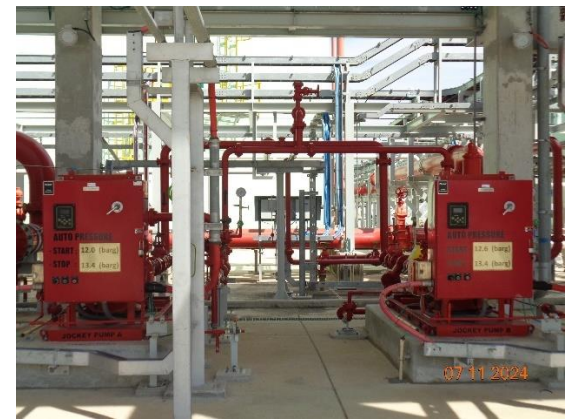
รูปที่ 2-51 เครื่องสูบน้ำรักษาแรงดันน้ำ (Jockey Water Pump)
