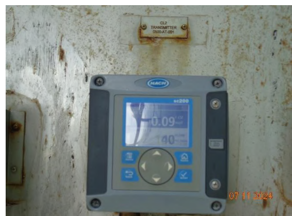
รูปที่ 2-16 อุปกรณ์ตรวจวัดคลอรีนอิสระอย่างต่อเนื่อง
