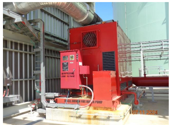
รูปที่ 2-53 เครื่องสูบน้ำใช้น้ำมันดีเซล (Diesel Driven Firewater Pump)
