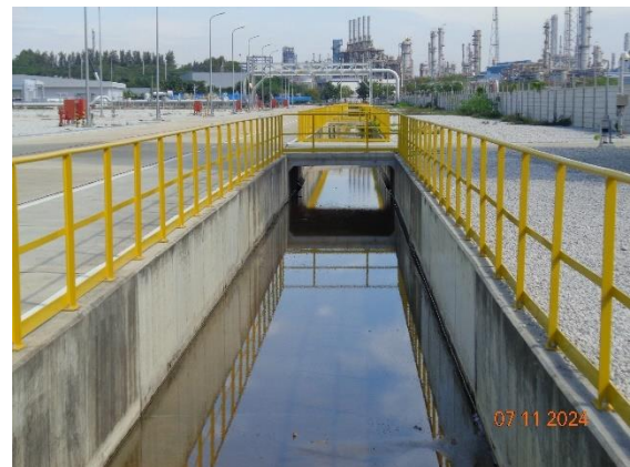
รูปที่ 2-18 ระบบระบายน้ำฝนในพื้นที่โครงการ
