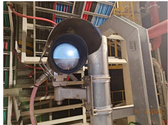
รูปที่ 2-45 เครื่องตรวจจับก๊าซ (Gas detector) บริเวณท่าเทียบเรือ
