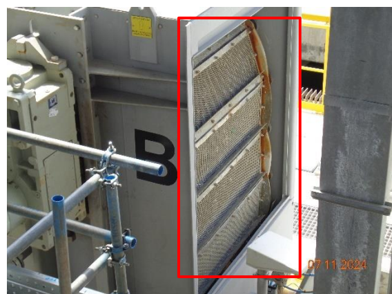
รูปที่ 2-20 ตะแกรงละเอียดบริเวณจุดรับน้ำทะเลเข้า
