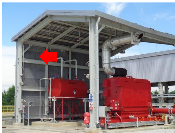
รูปที่ 2-13 กำแพงกันเครื่องจักรที่มีเสียงดัง
