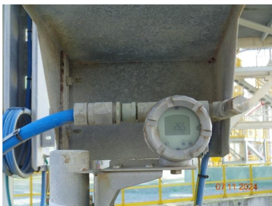
รูปที่ 2-15 อุปกรณ์ตรวจวัดอุณหภูมิของน้ำทะเลอย่างต่อเนื่อง (Temperature Transmitter)
