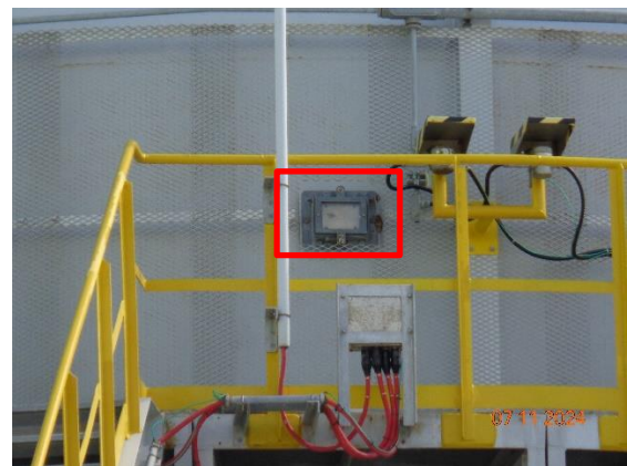
รูปที่ 2-8 ช่องกระจก (Sight glass) ที่ระบบหอเผา
