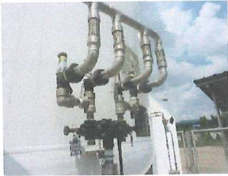
รูปการทดสอบและตรวจสอบอุปกรณ์ควบคุมความดันก๊าซเกินพิกัดแบบระบายสถานที่ใช้ LNG
