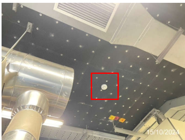
รูปที่ 2-41 อุปกรณ์ตรวจจับควันภายในห้องเครื่อง ไฟฟ้า (Smoke Detector)
