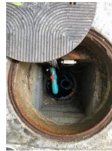
จุดระบายน้ำออกจากระบบบำบัดน้ำเสีย B
