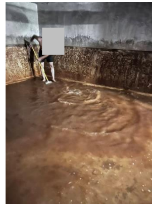
รูปที่ 2-79 ล้างถังเก็บน้ำใช้
