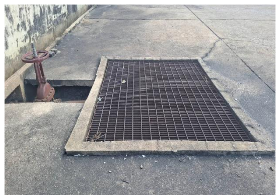
รูปที่ 2-20 บ่อคอนกรีตสำหรับรวบรวมน้ำเสียปนเปื้อนโมลาส
