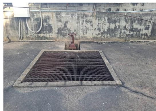
รูปที่ 2-20 บ่อคอนกรีตสำหรับรวบรวมน้ำเสียปนเปื้อนโมลาส
