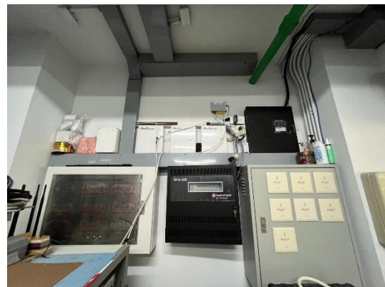
รูปที่ 2-38 แผงควบคุม Fire Alarm
