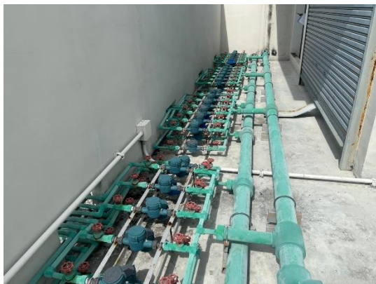
รูปที่ 2-37 มิเตอร์น้ำ
