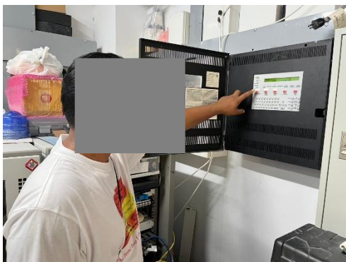
รูปที่ 2-45 ตรวจสอบแผงควบคุม Fire Alarm
