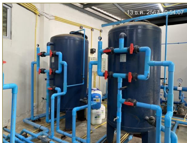
รูปที่ 2.29 ระบบกรองน้ำ
