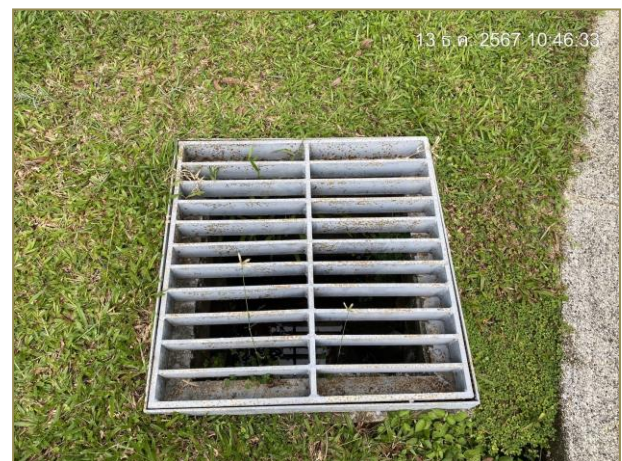
รูปที่ 2.14 ตะแกรงดักขยะ
