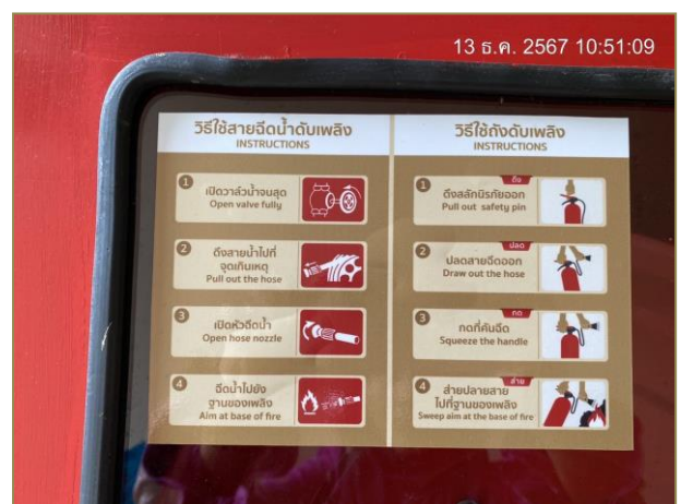
รูปที่ 2.23 ระบบป้องกันอัคคีภัย (ต่อ)
