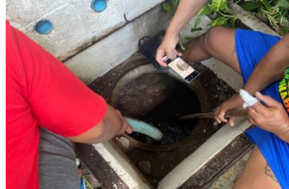
ภาพที่ 2.2-17 การสูบลบและไขนํ้าจากบ่อบำบัดน้ำเสีย
