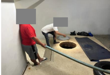
ภาพที่ 2.2-17 การสูบลบและไขนํ้าจากบ่อบำบัดน้ำเสีย
