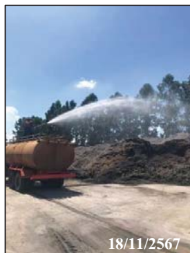
ภาพที่ 18 ฉีดพรมน้ำผิวหน้ากองเถ้าระหว่างรอกขนส่งกรณีหน้ากองเถ้าแห้ง
