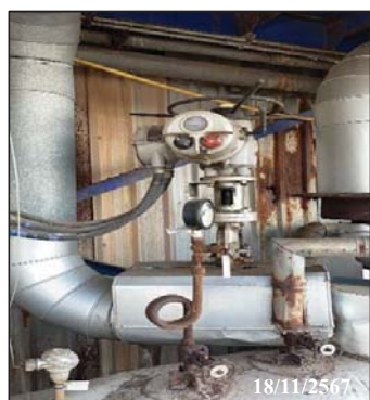
ภาพที่ 66 ติดตั้งชุด Bypass valve เพื่อลดความดันของไอน้ำ
