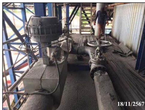
ภาพที่ 65 ติดตั้งวาล์วควบคุม (Control valve)
