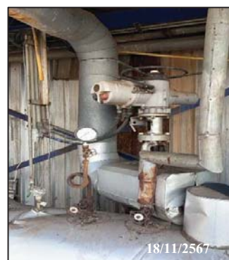
ภาพที่ 66 ติดตั้งชุด Bypass valve เพื่อลดความดันของไอน้ำ
