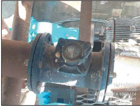
ภาพที่ 32 มาตรวัดน้ำบริเวณจุดสูบน้ำจากแม่น้ำปิง
