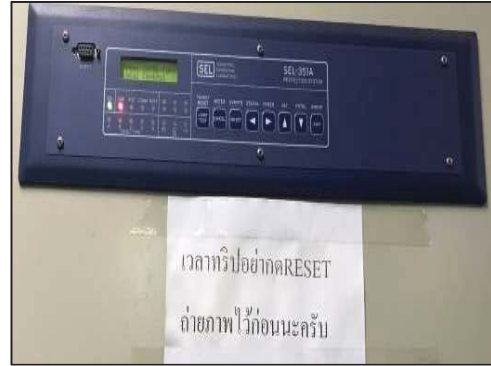
ภาพที่ 67 ติดตั้งอุปกรณ์ป้องกันป้องกันกระแสเกิน (Over current relays), อุปกรณ์วัดอุณหภูมิของขดลวด, อุปกรณ์ป้องกันแรงดันไฟฟ้าสูงเกิน, อุปกรณ์ป้องกันกำลังไฟฟ้าย้อนกลับ, อุปกรณ์ป้องกันการรั่วไหลของแรงดันไฟฟ้า
