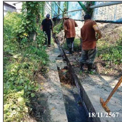
ภาพที่ 28 การขุดลอกการระบายน้ำ
