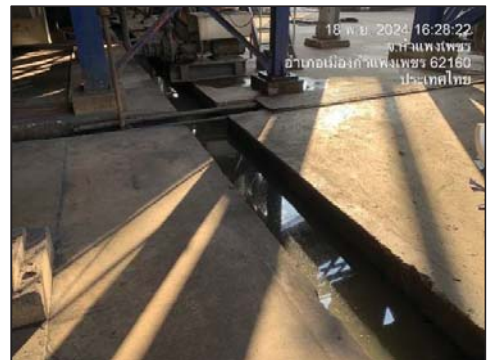
ภาพที่ 14 รางระบายน้ำรอบกองเก็บกากอ้อย
