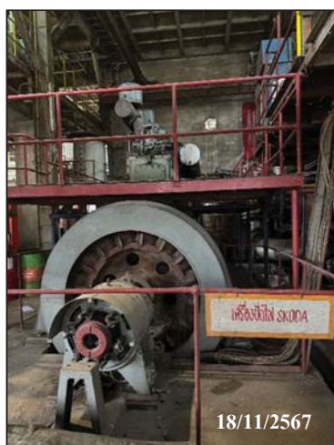
ภาพที่ 56 เครื่องกำเนิดไฟฟ้าสำรอง
