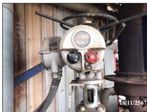
ภาพที่ 65 ติดตั้งวาล์วควบคุม (Control valve)
