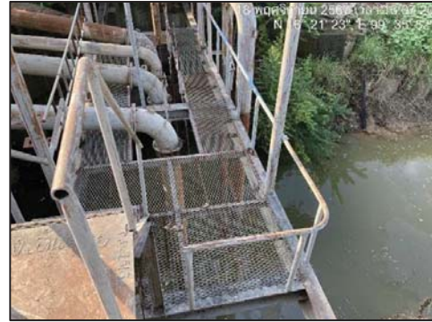
ภาพที่ 33 ตะแกรงตาถี่ปลายท่อสูบน้ำจากแม่น้ำปิง
