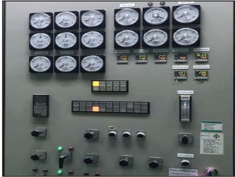
ภาพที่ 67 ติดตั้งอุปกรณ์ป้องกันป้องกันกระแสเกิน (Over current relays), อุปกรณ์วัดอุณหภูมิของขดลวด, อุปกรณ์ป้องกันแรงดันไฟฟ้าสูงเกิน, อุปกรณ์ป้องกันกำลังไฟฟ้าย้อนกลับ, อุปกรณ์ป้องกันการรั่วไหลของแรงดันไฟฟ้า
