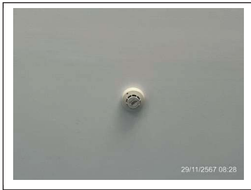
รูปที่ 2.14-6 เครื่องตรวจจับควัน
