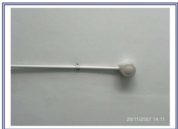
รูปที่ 3.1-49 เครื่องตรวจจับความร้อน
