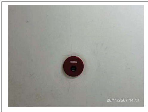
รูปที่ 2.14-8 อุปกรณ์แจ้งเหตุเพลิงไหม้ ด้วยมือ
