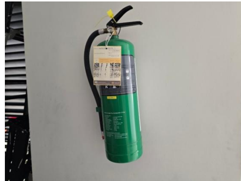
ถังดับเพลิงแบบมือถือ พร้อมคำแนะนำการใช้งาน
