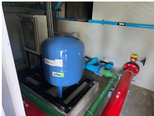
ถังเก็บน้ำชั้นดาดฟ้าและปั้มน้ำใช้
