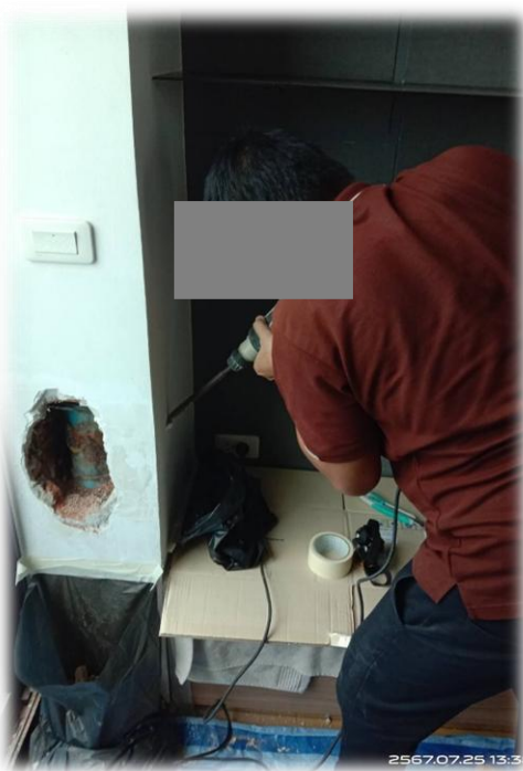
ซ่อมแซมท่อน้ำทิ้งส่วนกลางที่รั่วซึม ภายในผนังห้องชุด 8/203
