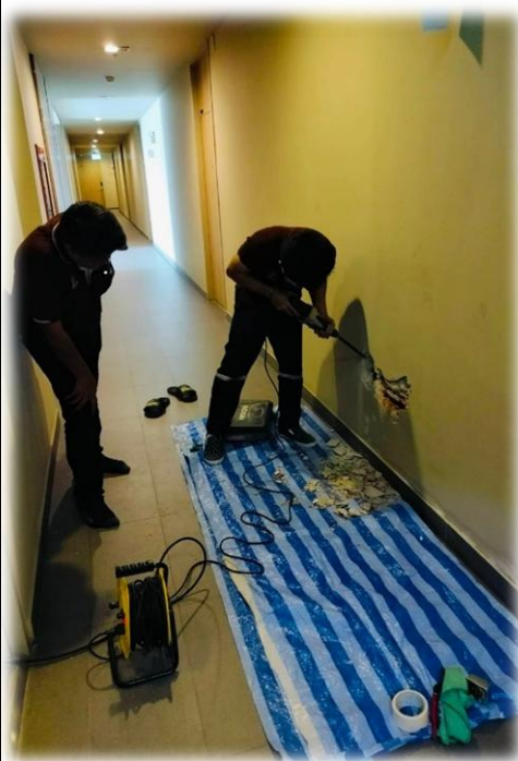
แก้ไขน้ำรั่วซึมบริเวณผนังโถงทางเดิน ส่วนกลาง ชั้น 21
