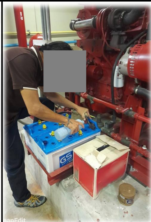
ตรวจเช็คและบำรุงรักษาระบบสูบน้ำ ดับเพลิงของอาคารชุด ชั้น G
