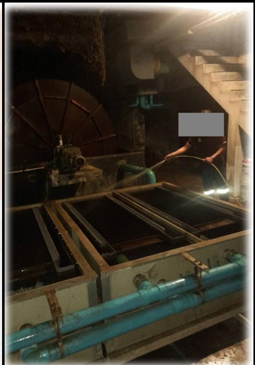
ตรวจเช็คและบำรุงรักษาระบบบำบัดน้ำ เสียของอาคารชุด ชั้น G
