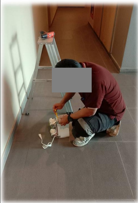
เปลี่ยนแบตเตอรี่สำหรับไฟฉุกเฉิน บริเวณโถงทางเดินประจำชั้น 5 - 23
