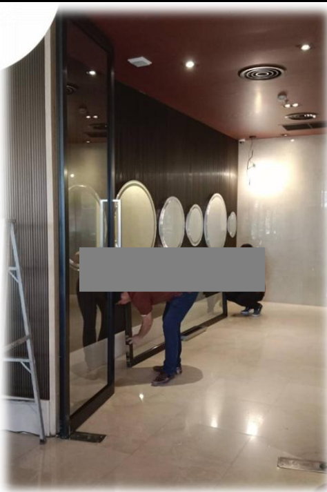
ซ่อมแซมใช้คและบานพับประตูกระจกทางเข้าออกโถงรับรอง ชั้น G
