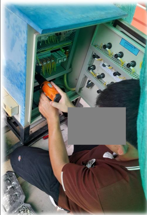
ซ่อมเปลี่ยนอุปกรณ์ควบคุม กระแสไฟฟ้าของเครื่องควบคุมระบบ แรงดันน้ำประปาของอาคารชุด
