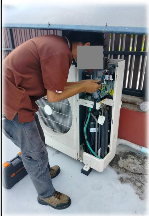
ตรวจสอบและเปลี่ยนแคปาซิเตอร์พัด ลมของเครื่องปรับอากาศประจำ ห้องควบคุมลิฟต์โดยสารของอาคาร
