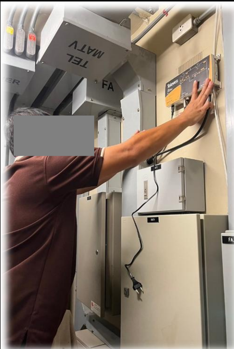
ซ่อมเปลี่ยนอุปกรณ์ควบคุม กระแสไฟฟ้าของเครื่องควบคุมระบบ แรงดันน้ำประปาของอาคารชุด
