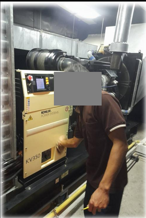
ตรวจเช็คและบำรุงรักษาระบบไฟฟ้า สำรองของอาคารชุด ชั้น G
