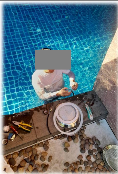
เปลี่ยนหลอดไฟใต้สระว่ายน้ำของอาคารชุด ชั้น 5
