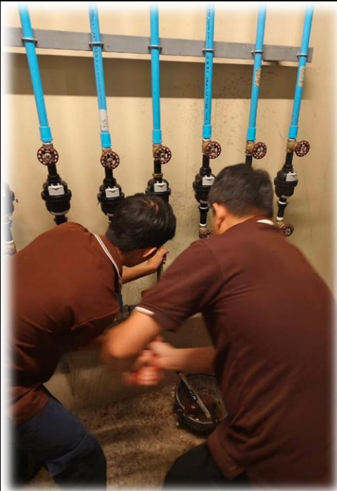
ซ่อมแซมท่อต่อมิเตอร์น้ำประปาบริเวณห้องชาร์ปน้ำ ชั้น 56
