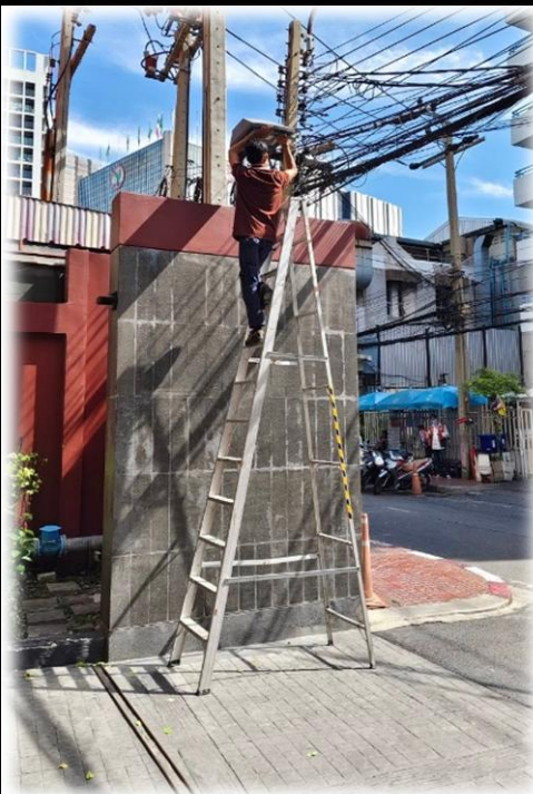
เปลี่ยนหลอดไฟสปอร์ตไลท์ด้านหน้า ทางเข้าออกโครงการ ชั้น G
