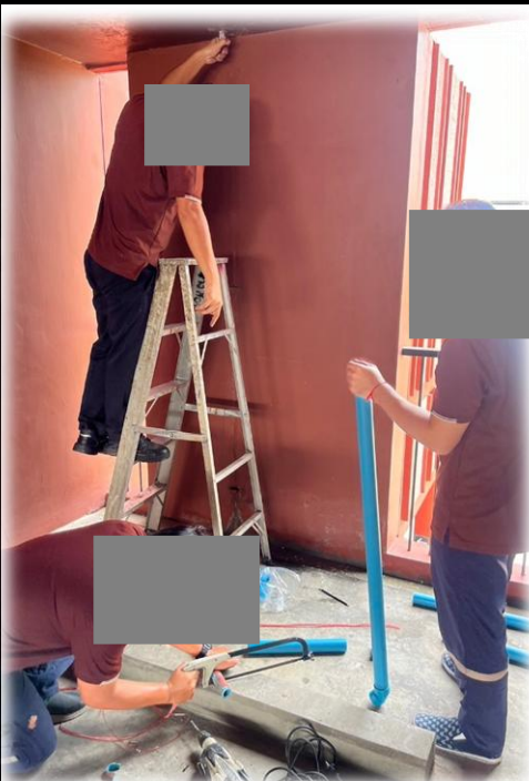
ซ่อมแซมท่อน้ำทิ้งสำหรับสระว่ายน้ำ ของอาคารชุด
