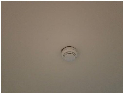
รูปที่ 2-24 เครื่องตรวจจับควัน
