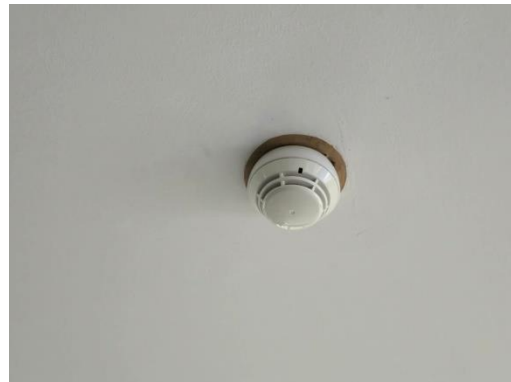
รูปที่ 2-24 เครื่องตรวจจับควัน
