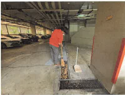
ภาพที่ 2-33 เจ้าหน้าที่ทำความสะอาดรางระบายน้ำ
