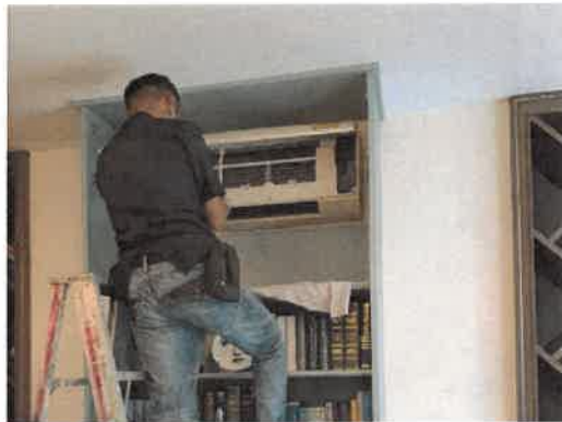
ภาพที่ 2-21 ล้างทำความสะอาดเครื่องปรับอากาศ
