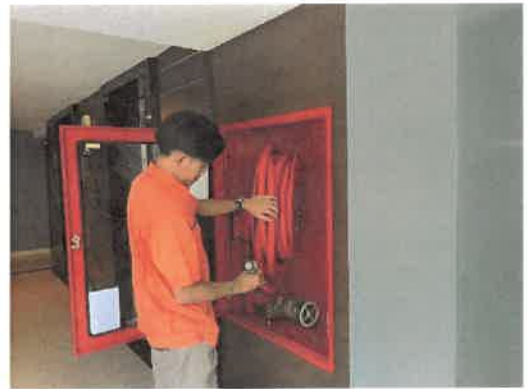
ภาพที่ 2-36 ตรวจสอบระบบป้องกันอัคคีภัย
