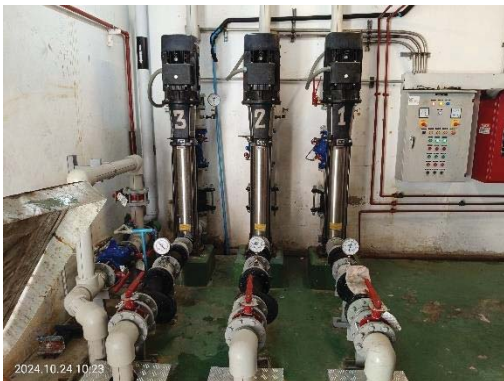
ปั๊มสูบน้ำใช้ขึ้นถังเก็บน้ำบาดาล
