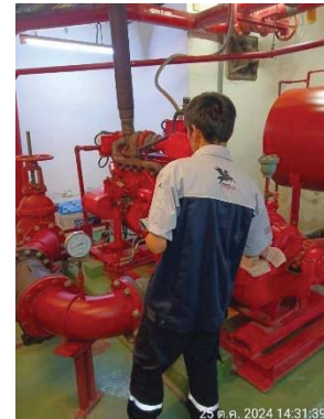
ตรวจสอบปั๊มสูบน้ำดับเพลิง
