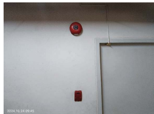
Manual Station และ Alarm bell
