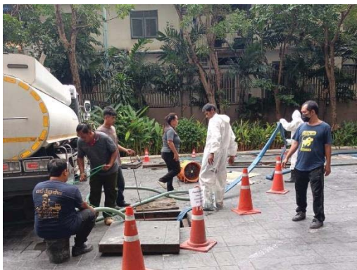
รถเข้าสูบไขมันและ ตะกอนส่วนเกินจากระบบบำบัดน้ำเสีย
