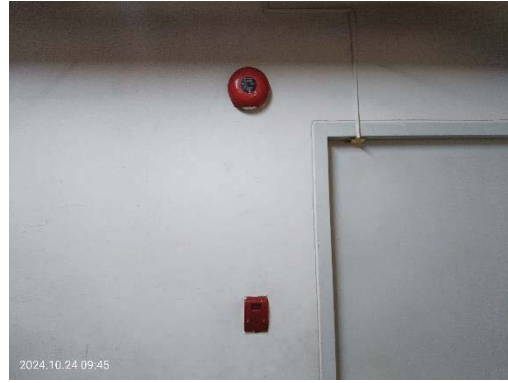
Manual Station และ Alarm bell
