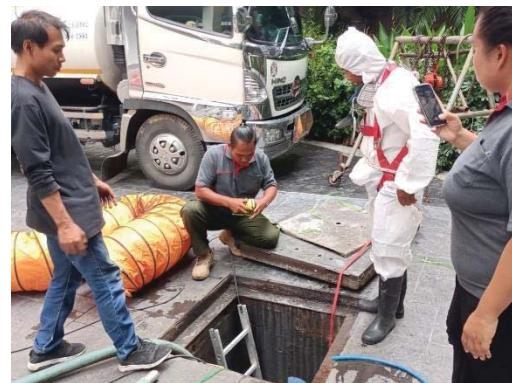
รถเข้าสูบไขมันและ ตะกอนส่วนเกินจากระบบบำบัดน้ำเสีย
