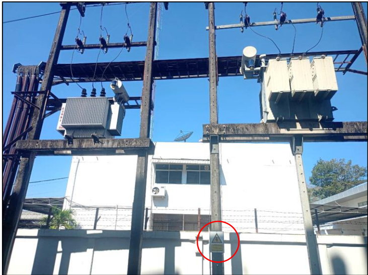
เสาไฟฟ้าและหม้อแปลงไฟฟ้า พร้อมติดป้ายเตือน “อันตรายไฟฟ้าแรงสูง”
