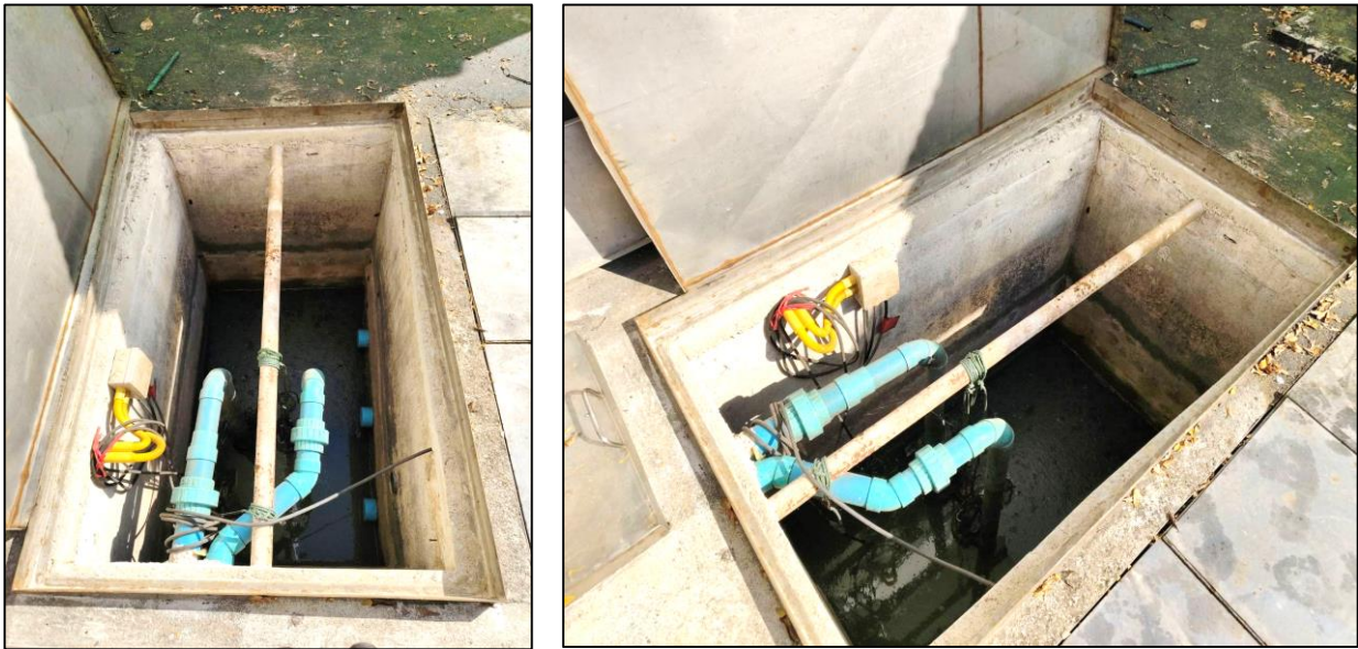
สภาพบ่อกักน้ำ บ่อบรรจบน้ำ อยู่ในสภาพดีไม่มีสิ่งอุดตัน
