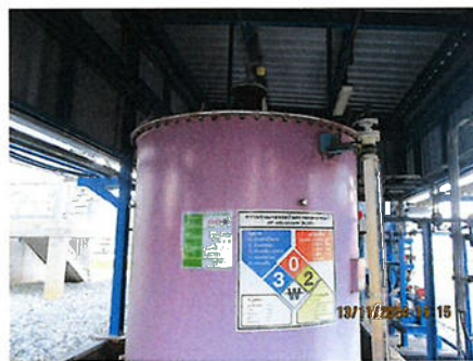
ภาพที่ 2-58 Activated carbon บริเวณถังเก็บสารเคมี
