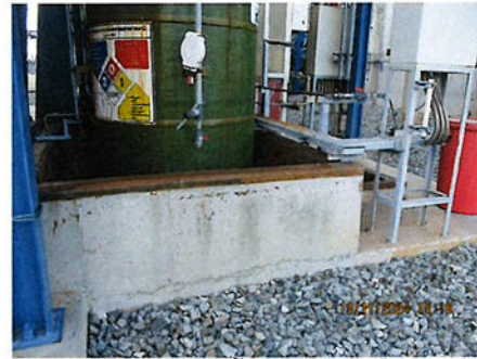
ภาพที่ 2-57 คันกั้นสารเคมีหกรั่วไหล
