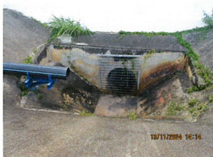
ภาพที่ 2-26 จุดระบายน้ำฝนที่เชื่อมต่อกับ ระบบระบายน้ำฝนของนิคมฯ
