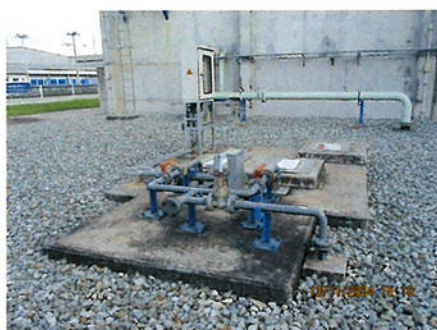
ภาพที่ 2-26 จุดระบายน้ำฝนที่เชื่อมต่อกับ ระบบระบายน้ำฝนของนิคมฯ
