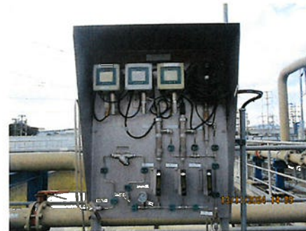
ภาพที่ 2-16 ระบบ Online Monitoring บริเวณบ่อบำบัดน้ำหล่อเย็น
