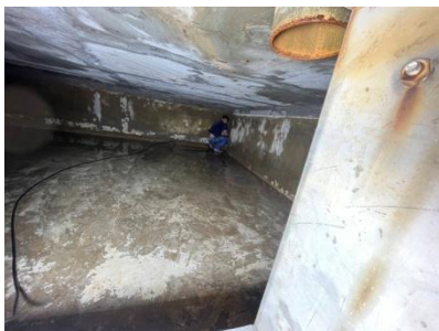
การล้างถังเก็บน้ำใช้ชั้นคาตฟ้า
