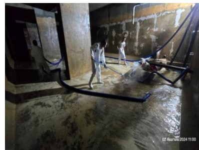
การล้างถังเก็บน้ำใช้ชั้นใต้ดิน
