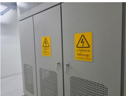
ติดตั้งป้ายระวังอันตรายกระแสไฟฟ้าแรงสูง
