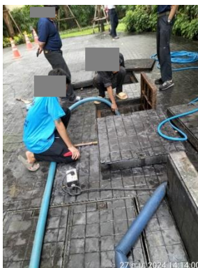
รูปที่ 2-27 ประสานให้สำนักงานเขตวัฒนามาสูบตะกอนระบบบำบัดน้ำเสีย
