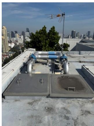
รูปที่ 2-36 ถังสำรองน้ำชั้นดาดฟ้า และถังสำรองน้ำชั้นใต้ดิน
