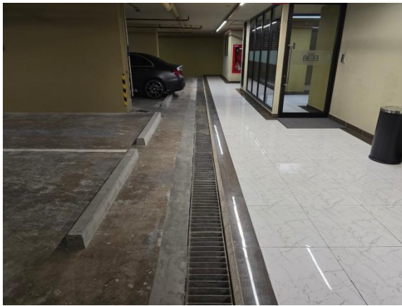
รูปที่ 2-34 จัดให้ชั้นใต้ดินที่ 1-2 มีท่อระบายน้ำเพื่อรวบรวมน้ำฝนไปยังบ่อสูบน้ำ
