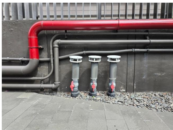
รูปที่ 2-31 ระบบกำจัดก๊าซมีเทนและละอองที่เกิดจากระบบ บำบัดน้ำเสีย
