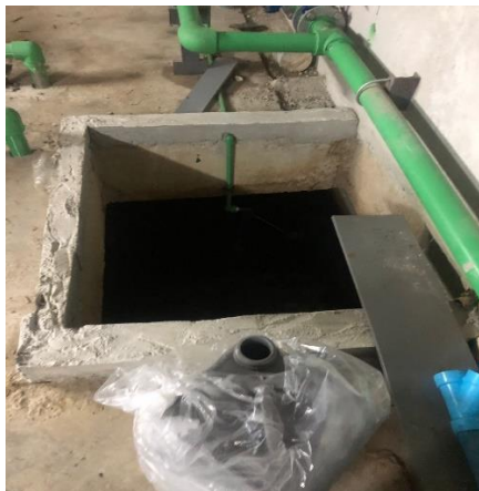
ภาพที่ 20.ถังน้ำสำรองดับเพลิง
