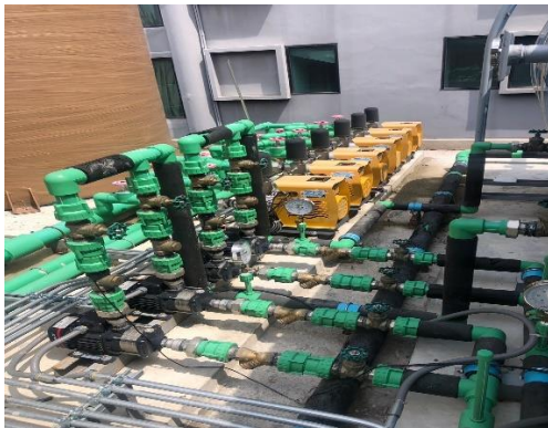
ภาพที่ 12.ระบบวาล์วควบคุมน้ำใช้
