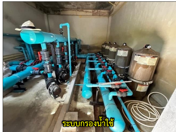
รูปที่ 3-10 บ่อน้ำบาดาล และระบบกรองน้ำในโครงการ
