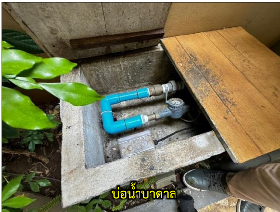
รูปที่ 3-10 บ่อน้ำบาดาล และระบบกรองน้ำในโครงการ
