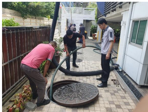
เจ้าหน้าที่ทำความสะอาดบ่อหน่วงน้ำ
