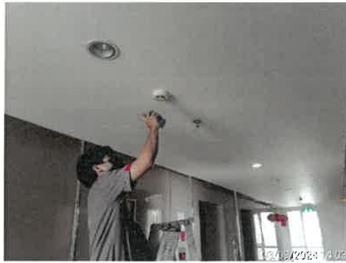
ช่างตรวจสอบเช็คอุปกรณ์ป้องกันและแจ้งเหตุเพลิงไหม้เฟส 2
