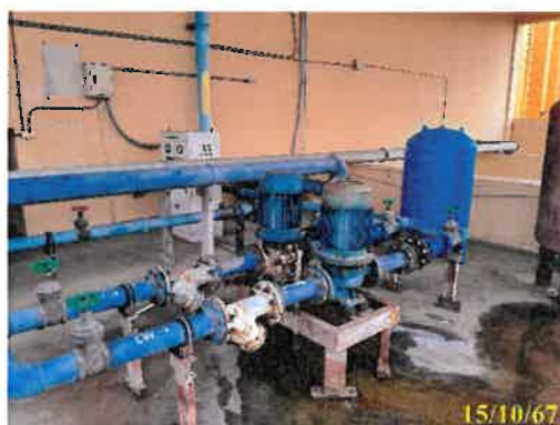
ถังเก็บน้ำบาดาล พร้อมเครื่องปั้มน้ำอาคาร A
