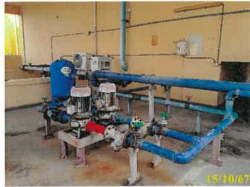
ถังเก็บน้ำควดฟ้า พร้อมเครื่องปั้มน้ำอาคาร B
