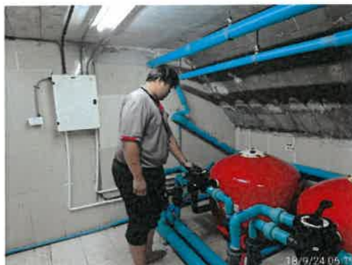
ช่างทำความสะอาดเครื่องกรองน้ำส้วมว่ายน้ำ
