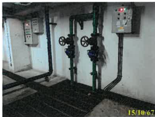
ระบบการระบายน้ำชั้นใต้ดินอาคาร A
