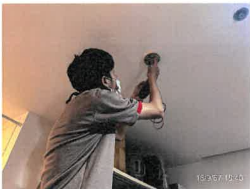
ช่างตรวจเช็คอุปกรณ์ป้องกันและแจ้งเหตุเพลิงไหม้ เฟส 1
