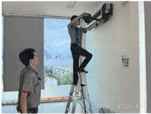
ช่างดำเนินการทำความสะอาดเครื่องปรับอากาศพื้นที่ส่วนกลาง
