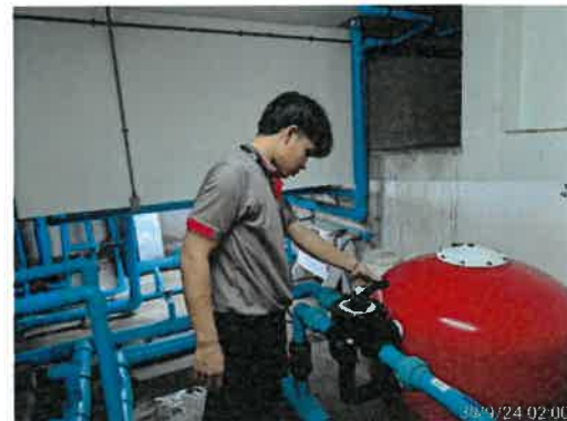
ช่างทำความสะอาดเครื่องกรองน้ำส้วมว่ายน้ำ
