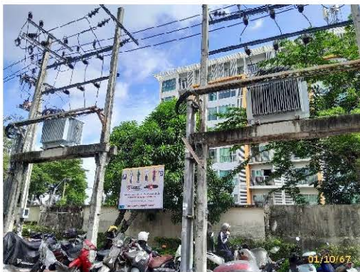
หม้อแปลงไฟฟ้าแต่ละอาคาร
