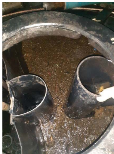
การสูบน้ำและไขมันครั้งสุดท้าย
