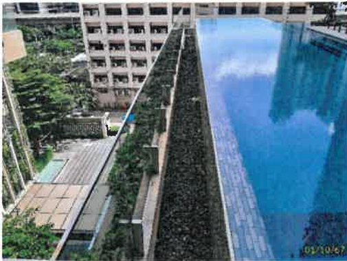
รางระบายน้ำล้นสระว่ายน้ำอาคาร A
