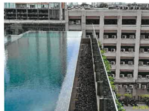
รางระบายน้ำล้นสระว่ายน้ำอาคาร B
