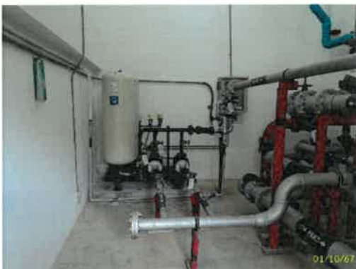
ปั๊ม และถังเก็บน้ำสำรองชั้นดาดฟ้าอาคาร B
