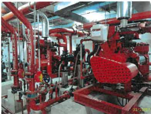
เครื่องสูบน้ำดับเพลิงอาคาร A
