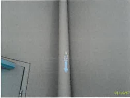
ท่อระบายน้ำฝนจากหลังคา
