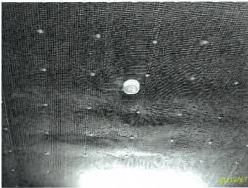
เครื่องตรวจจับความร้อนอาคาร A
