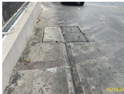
บ่อพักน้ำสุดท้ายก่อนระบายลงท่อสาธารณะ
