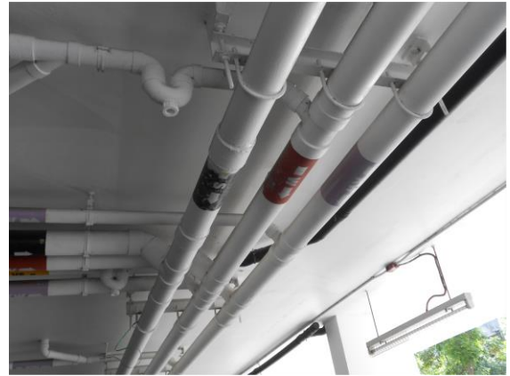
รูปที่ 2-18 ท่อน้ำทิ้ง และท่อน้ำประปาแยกสี
