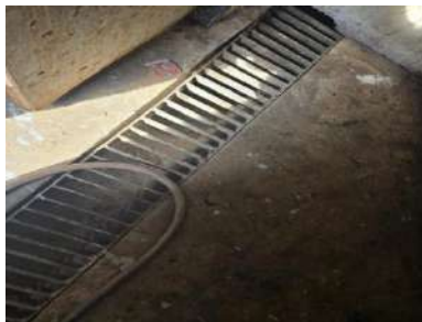
รูปที่ 2-26 ท่อรวบรวมน้ำจากการล้าง ห้องพักมูลฝอยรวม
