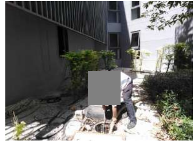
รูปที่ 2-9 สืบสิ่งปฏิกูล ตะกอนส่วนเกิน ไปกำจัดทุกเดือน
