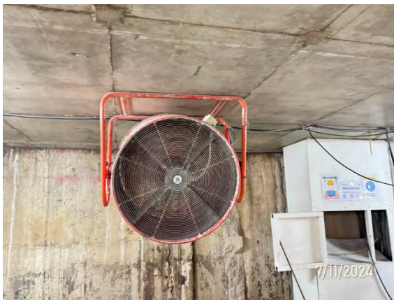
รูปที่ 2-59 ติดตั้งพัดลมระบายอากาศในพื้นที่อับอากาศ
