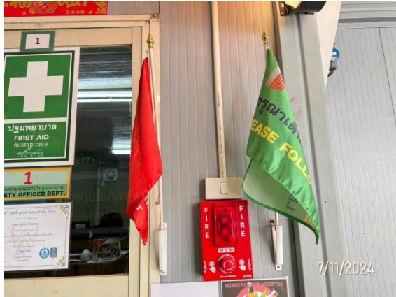
รูปที่ 2-68 อุปกรณ์แจ้งเหตุเพลิงไหม้ (Fire alarm)
