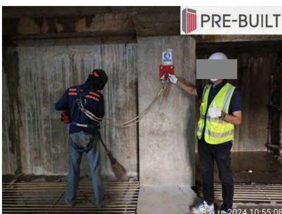
รูปที่ 2-57 การสวมใส่อุปกรณ์คุ้มครองความปลอดภัยและป้องกันการตกจากที่สูง
