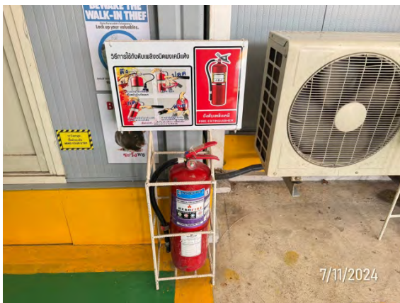
รูปที่ 2-43 ถังดับเพลิงเคมีและวิธีการใช้งาน
