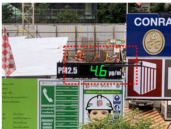
รูปที่ 2-15 ติดตั้งเครื่องตรวจวัดค่าฝุ่นละออง PM 2.5 แบบเรียลไทม์
