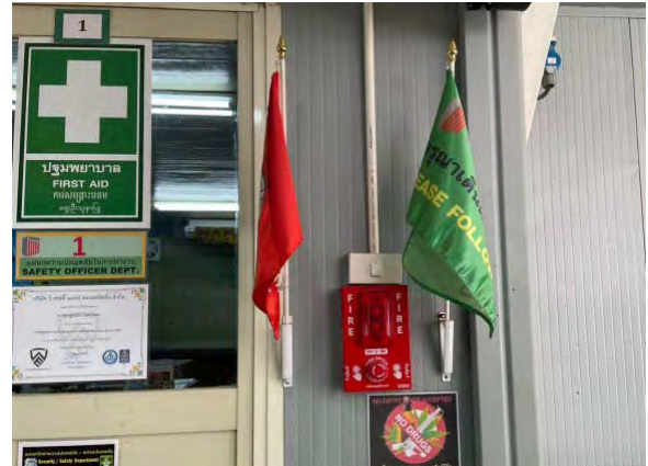
รูปที่ 2-68 อุปกรณ์แจ้งเหตุเพลิงไหม้ (Fire alarm)
