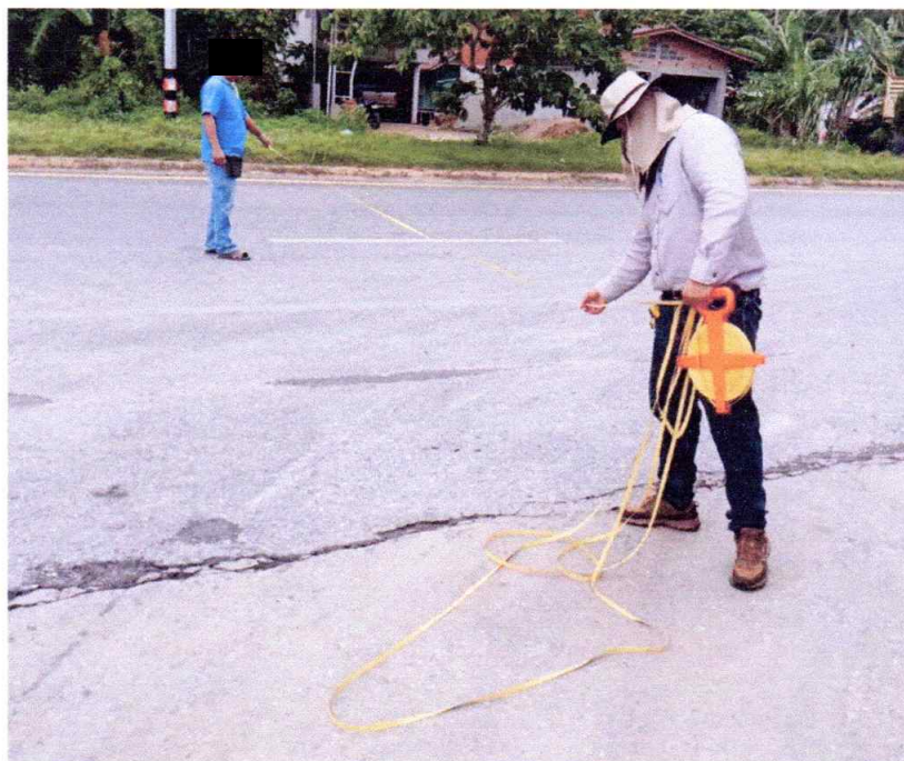
ดำเนินการสำรวจและซ่อมแซมถนนทางหลวงแอสฟัลต์ หมายเลข 409 บริเวณเชื่อมต่อกับทางเข้าของโรงโม่ที่มีสภาพเป็นหลุมให้กลับมาใช้งานได้สภาพเดิม
