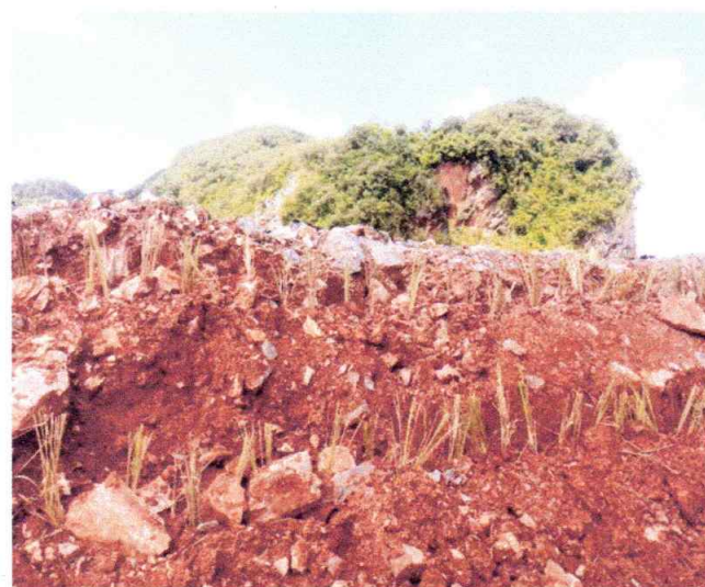
ดำเนินการทำคันดินและปลูกหญ้าแฝกเป็นพืชคลุมดินในพื้นที่ไม่ทำเหมือง ตามแนวเขตหลักหมุดที่ 5 - 6
