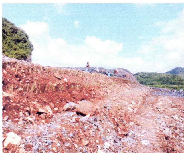
ดำเนินการทำคันดินและปลูกหญ้าแฝกเป็นพืชคลุมดินในพื้นที่ไม่ทำเหมือง ตามแนวเขตหลักหมุดที่ 5 - 6
