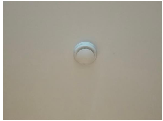
รูปที่ 2-75 เครื่องตรวจจับควัน (Smoke Detector)
